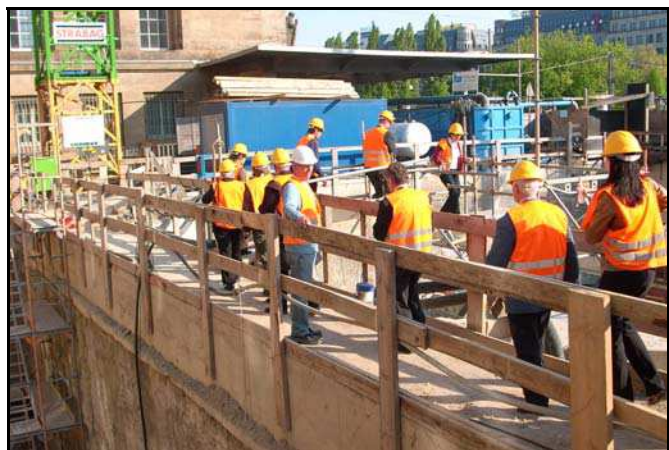
Fachexkursion – Baustellenbegehung City-Tunnel am Leipziger Hauptbahnhof
