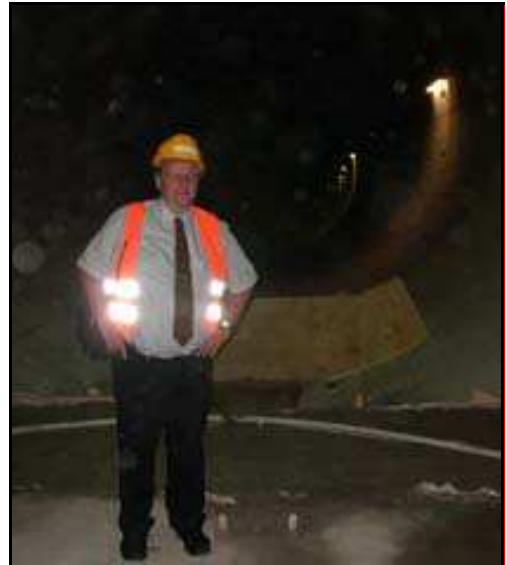
Befahrung der Baustelle des City-Tunnels Leipzig durch die Verbandsverwaltung
